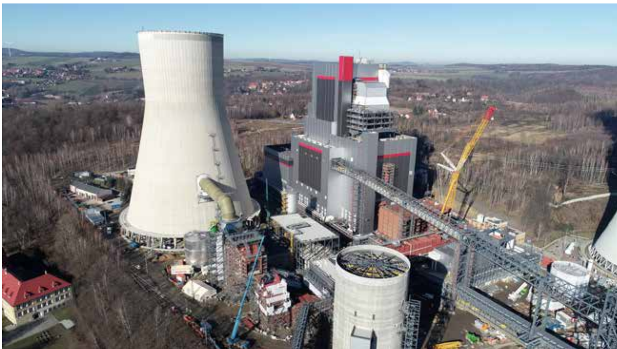
Budowa bloku w Elektrowni Turów
