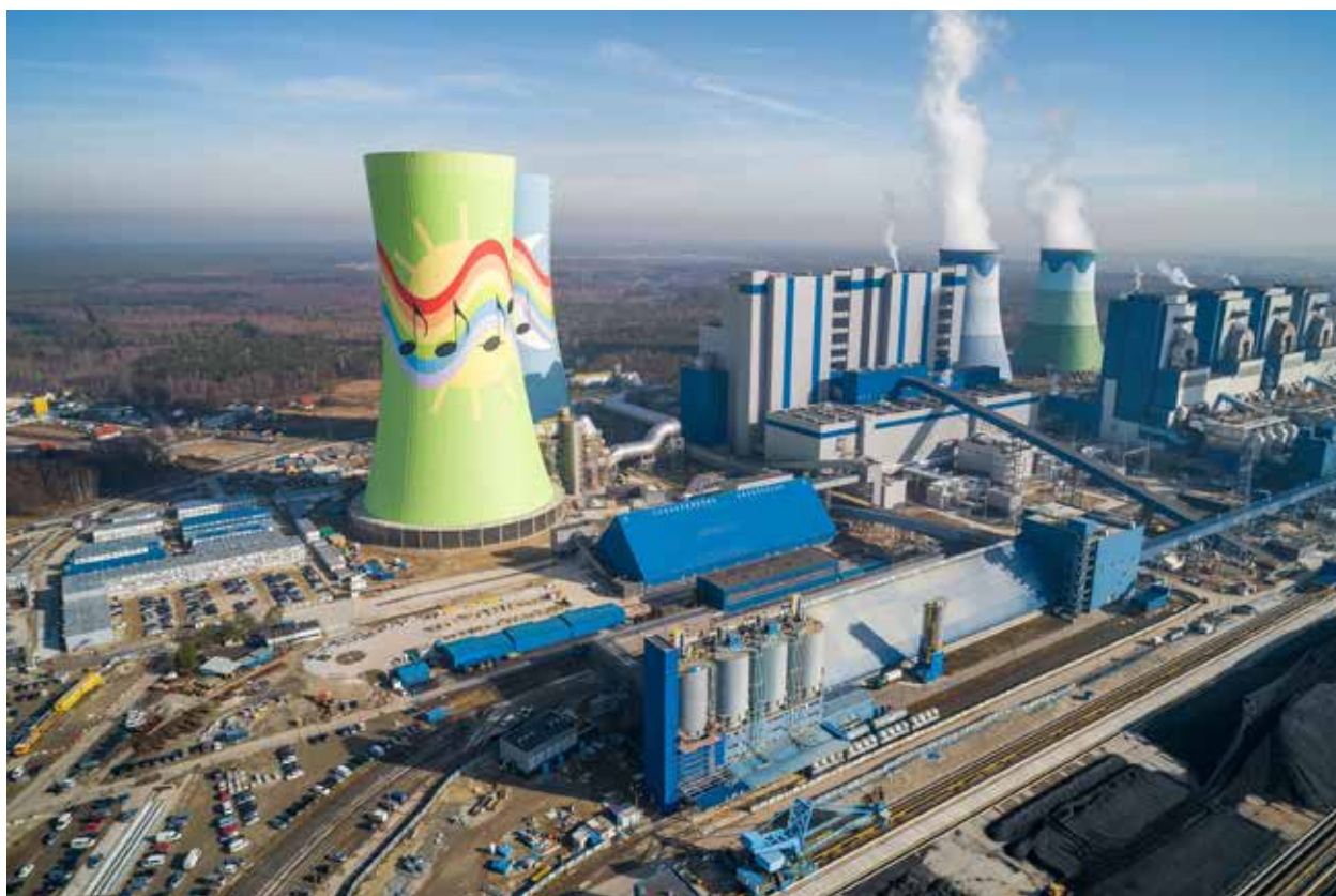
Inwestycja w Elektrowni Opole, marzec 2019
