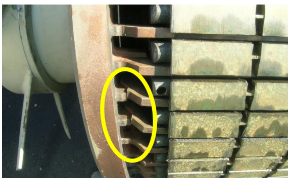
Rys. 10. Uszkodzenie wirnika silnika PICW
