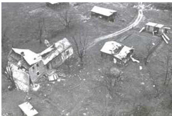
Ryc. 6. Zniszczenia budynku nr 5 położonego 610 m od epicentrum wybuchu (na podstawie [2])
