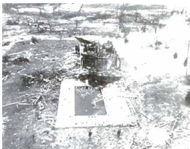
Ryc. 5. Pozostałości po budynku nr 1, położonym najbliżej epicentrum wybuchu (na podstawie [2])
