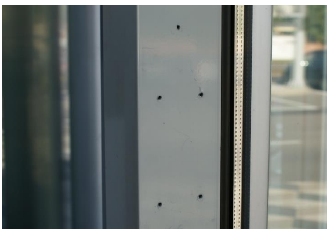
Rys. 7. Zdjęcie owierconego elementu, bez zabezpieczeń przed przedostaniem się dodatkowego powietrza, które na skutek różnicy temperatur może się skraplać na ściankach.
