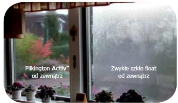
Rys. 12. Widok dwukomorowych energooszczędnych szyb zespolonych o identycznym współczynniku przenikania ciepła U=0,9W/m^2K . Po lewej stronie tafła zewnętrzna wykonana ze szkła samoczyszczącego Pilkington Activ™ od zewnątrz. Po prawej stronie tafła zewnętrzna wykonana ze szkła float od zewnątrz.[12]
