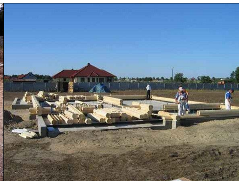
Rys. 10. Układanie konstrukcji (zgodnie z numeracją w projekcie) [2]
