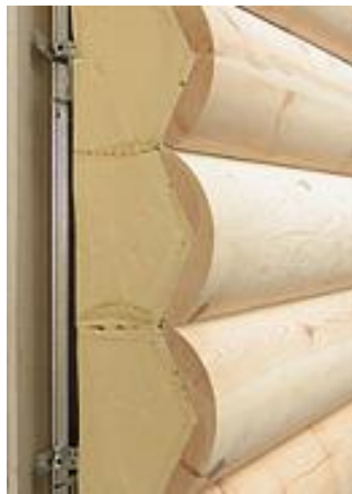
Rys. 4. Ściana z bala okrągłego jednostronnego (półbala) z wykończeniem od wewnątrz płytą G-K [2]
