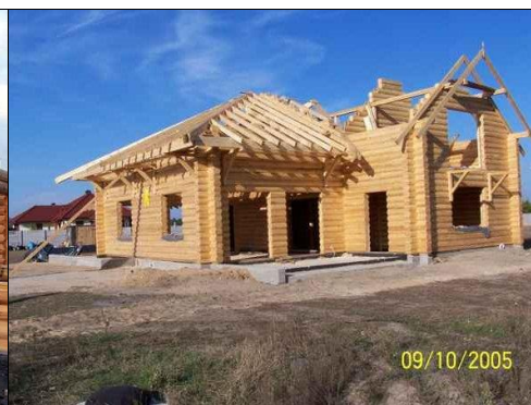
Rys. 14. Gotowa więźba nad niższą kondygnacją [2]
