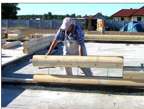
Rys. 11. Montaż M-Bala na podwalinie [2]
