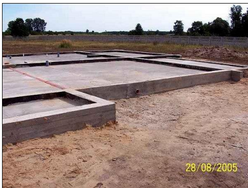
Rys. 9. Fundament po zdjęciu deskowania, gotowy do budowy w systemie M-Bal [2]
