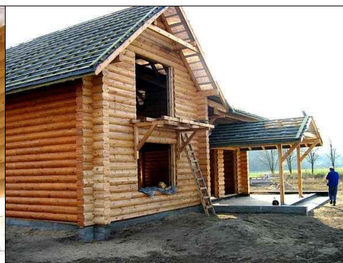
Rys. 16. Stan surowy otwarty budynku z M-Bali [2]
