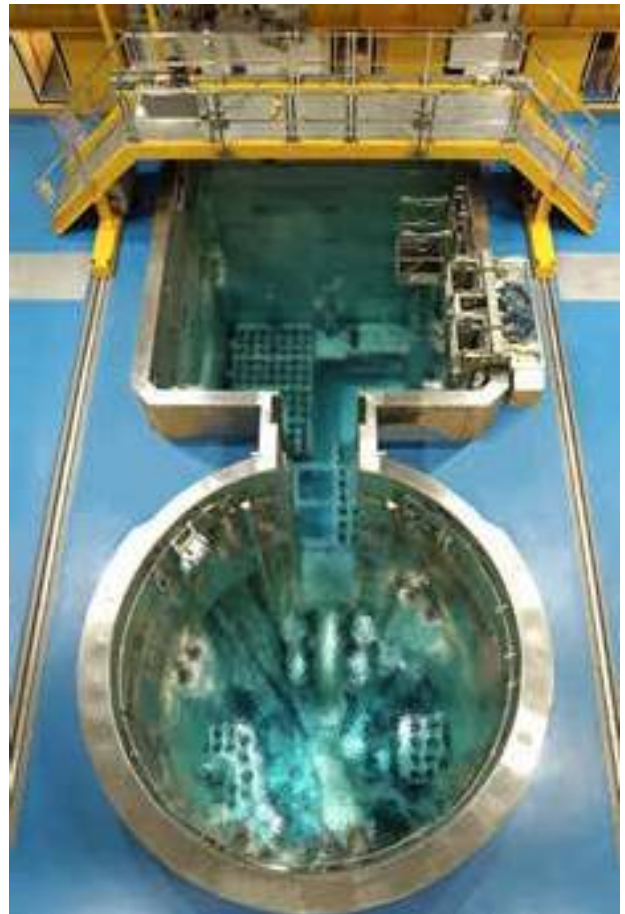
Fot. 2. Basen reaktora OPAL. Wykonany ze stali nierdzewnej i 4,5 m szerokości, zawiera wodę demineralizowaną, używaną do osłony i chłodzenia Photo 2. The OPAL reactor pools. Made of stainless steel and 4.5-metre (15 ft) wide, it contains demineralised water used for shielding and cooling
