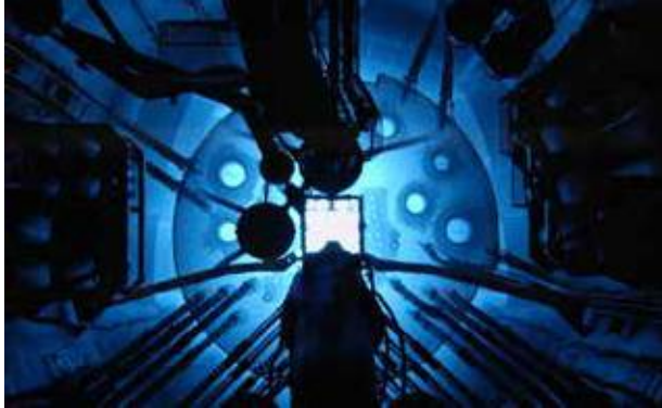
Fot. 5. Rdzeń reaktora OPAL (fot. ANSTO – z prezentacji Jason Chakovski & Andrew Frikken)
