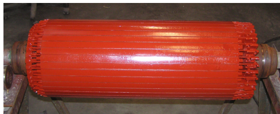
Rys. 15. Wirnik badanego silnika indukcyjnego po modernizacji
