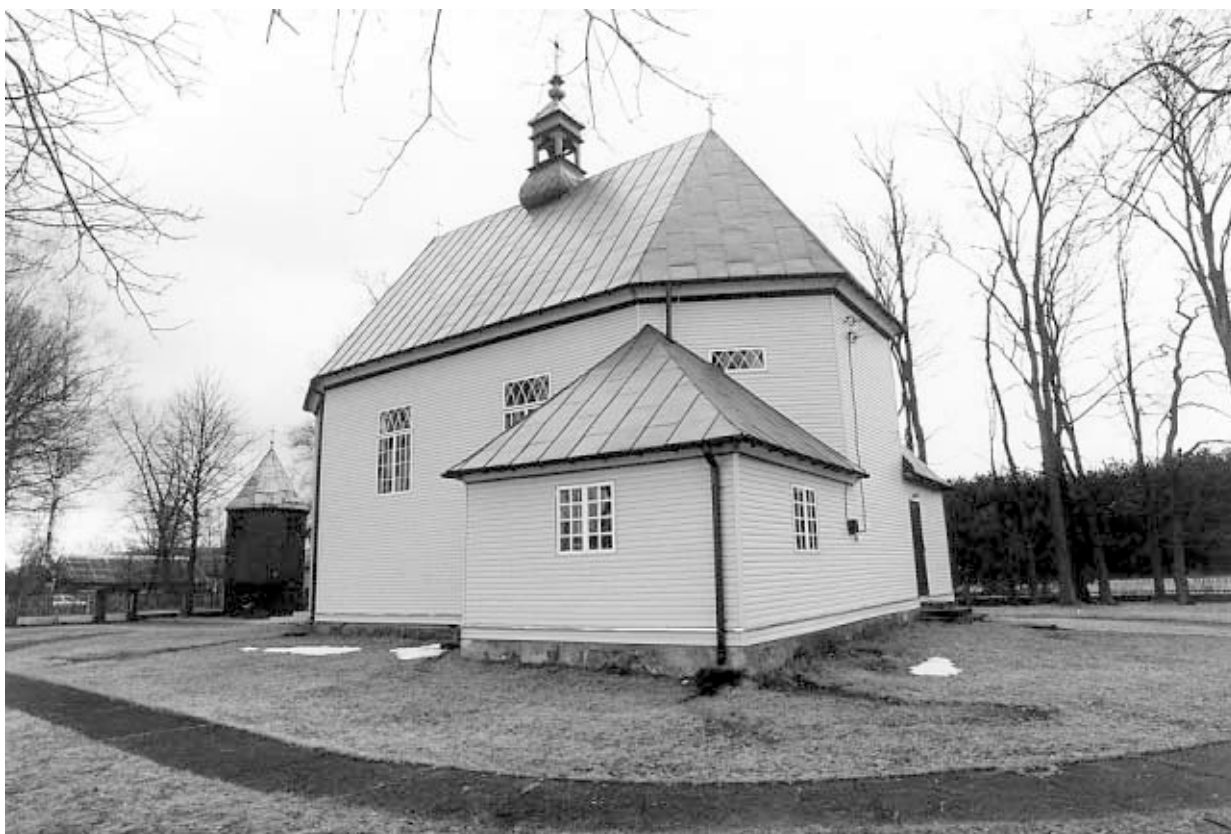
Zastosowanie nowoczesnego materiału wykończeniowego – sajdingu w obiciu ścian zewnętrznych kościoła w Olszewce, gm. Jednoróżec zniszczyło historyczną bryłę świątyni
