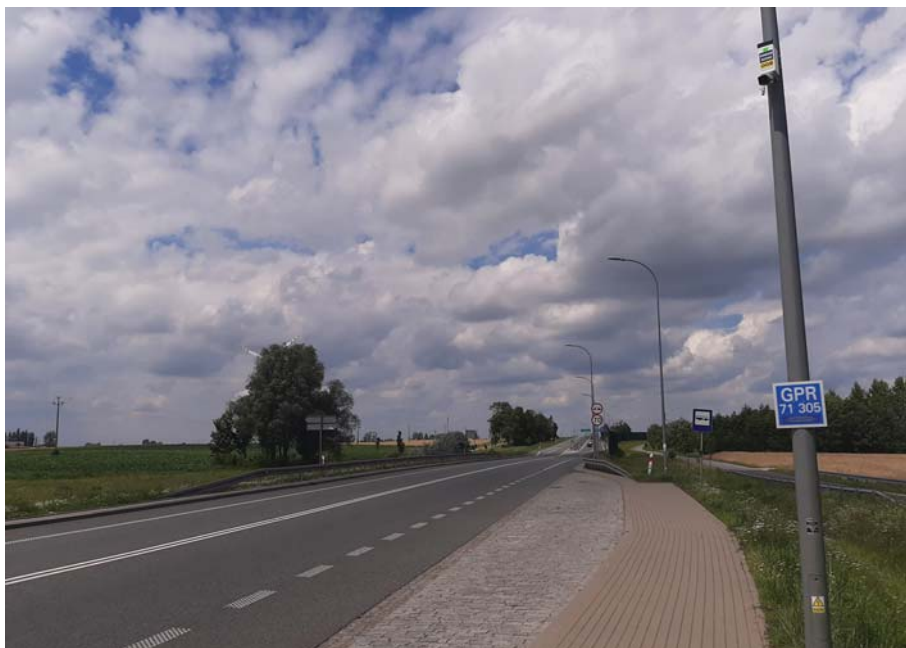
Fot. 1. Punkt pomiarowy z wideorejestracją
