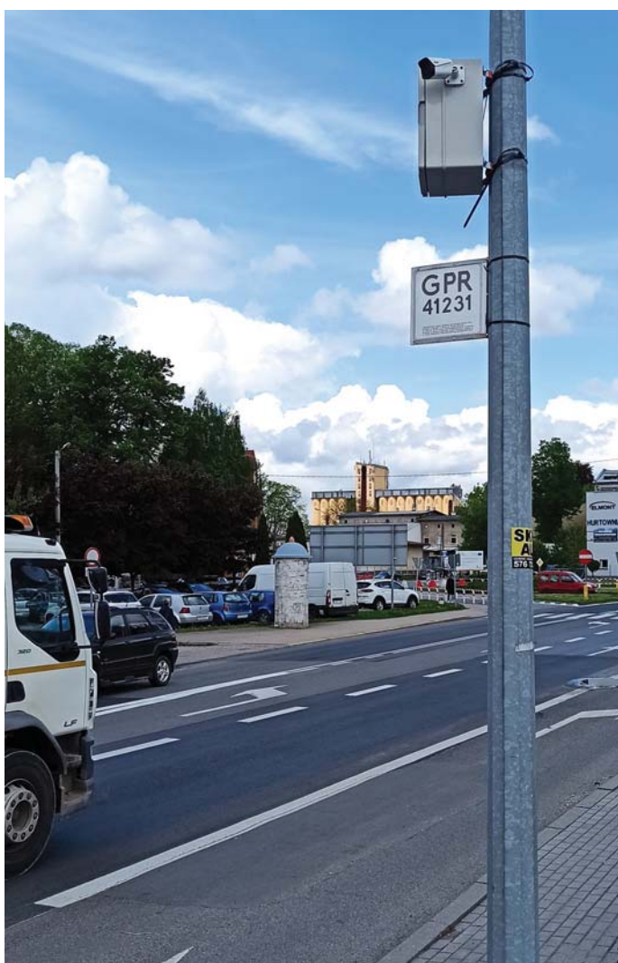
Fot. 2. Punkt pomiarowy z wideorejestracją
