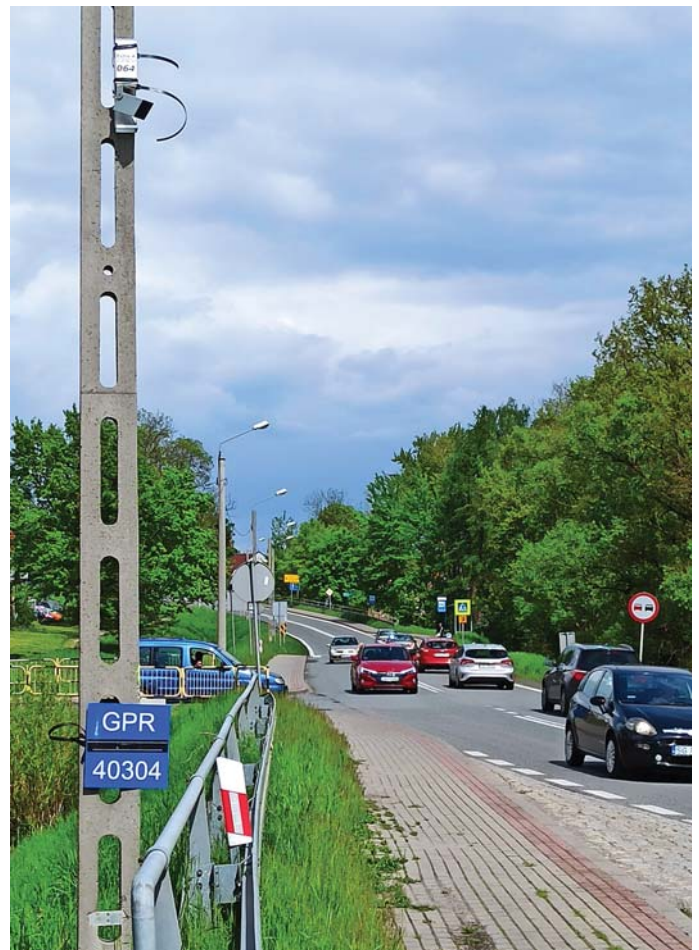
Fot. 3. Punkt pomiarowy z wideorejestracją
