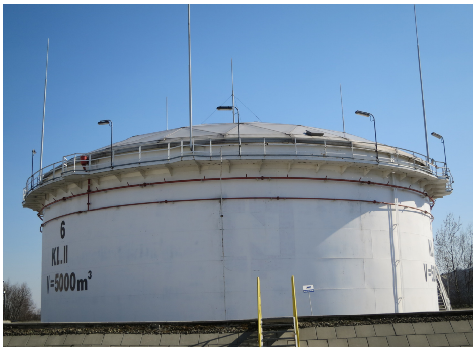
Rys. 5. Zbiornik stalowy z kopułą aluminiową i wewnętrznym dachem pływającym o pojemności 5000 m 3 przystosowany do magazynowania paliwa lotniczego typu JET (zdjęcie – J. Siudut)
