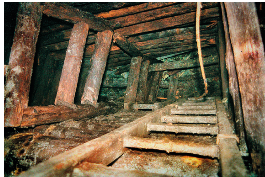
Ryc. 5. Obudowa szybu, przedział drabinowy, inwentaryzacja w 2006 r. (fot. M. Stysz)
