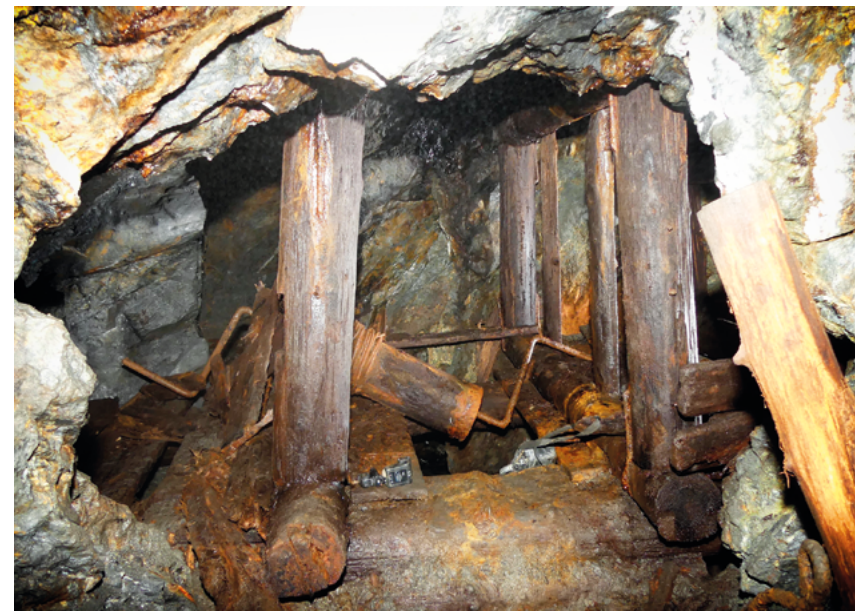
Ryc. 7. Zniszczony kołowrót, inwentaryzacja w 2008 r. (fot. M. Stysz)
