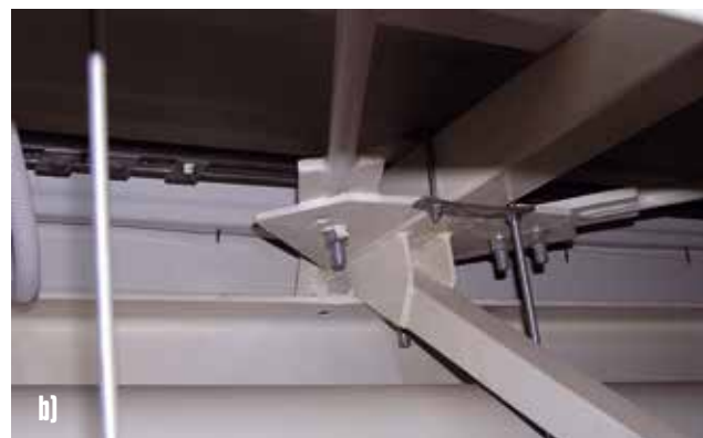
Rys. 4. Nieprawidłowe zamocowanie elementów stężących w zadaszeniu budynku halowego
