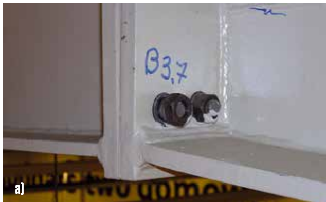
Rys. 6. Potężenia śrubowe z luźnymi nakrętkami
