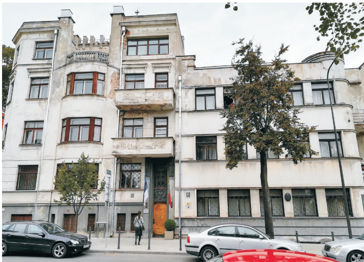
Ryc. 5. Budynek po prawej: Aleksandras Gordevičius, wielorodzinny budynek mieszkalny Jonasa Vileišisa, 1930. Budynek po lewej: Edmundas Frykas, wielorodzinny budynek mieszkalny Antanasa Gavrogkasa, 1932; fot. autor
