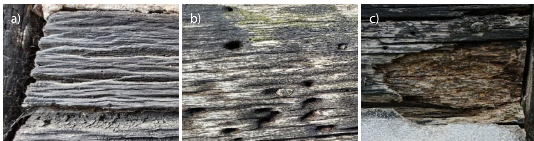
Rys. 4. Porażenie owadami, technicznymi szkodnikami drewna: a) Stępień (aktywne larwy), b) Sępólno Wielkie (nieaktywny owad), c) Drzewiany (aktywne larwy)
