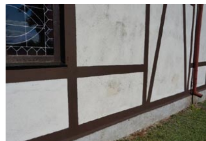
Rys. 2. Atrapa muru pruskiego (Świerzno, woj. pomorskie)
