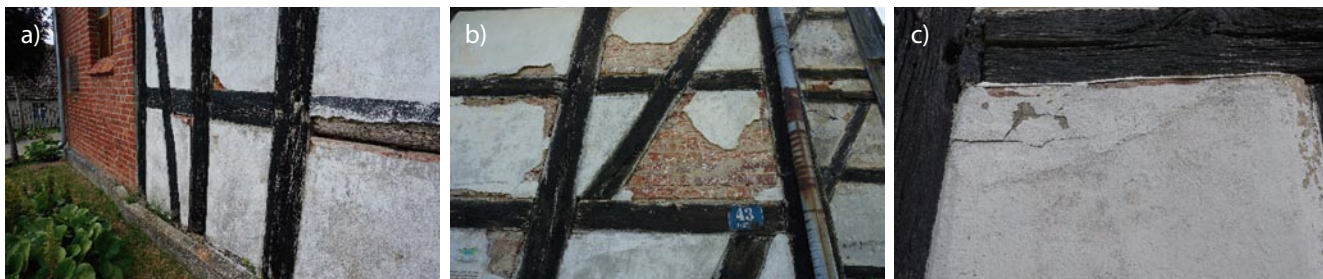
Rys. 8. Uszkodzenia tynków wypełnienia: a) Drzewiany, b) Mysłówice, c) Świerżno, woj. zachodniopomorskie
