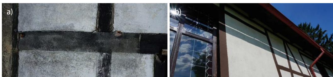
Rys. 6. Wymiany elementów szkieletu na mur: a) Drzewiany, b) Świerżno, woj. pomorskie
