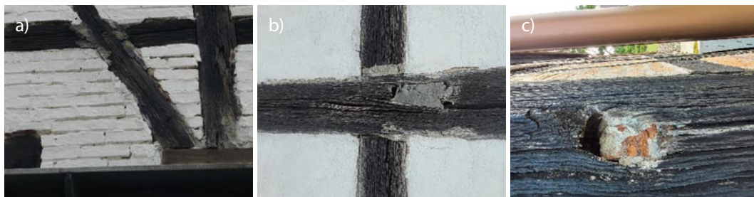
Rys. 5. Naprawy ubytków korozji ryglówki zaprawą cementową i murem: a) Dobrowo, b) Sępólno Wielkie, c) Stępień
