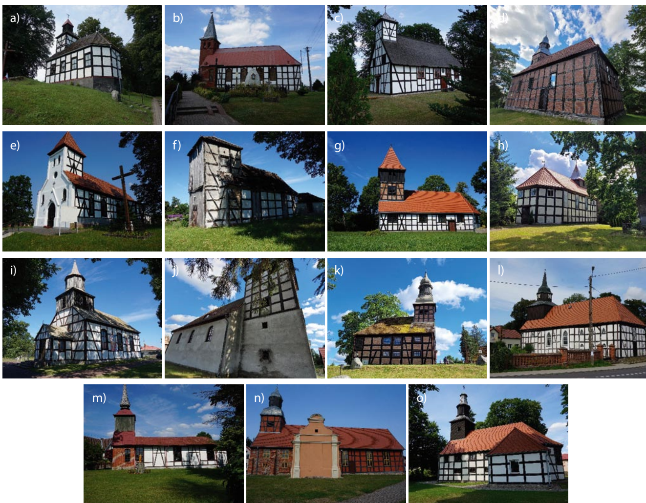
Rys. 1. Analizowane obiekty sakralne, zlokalizowane w miejscowościach: a) Dobrowo, b) Drzewiany, c) Garbno, d) Kazimierz, e) Kłanino, f) Mysłowice, g) Rokosowo, h) Sępólno Wielkie, i) Sławoborze, j) Stare Wierzchowo, k) Stępień, l) Świerzno (zachodniopomorskie), m) Świerzno (pomorskie), n) Tychowo, o) Żydowo
