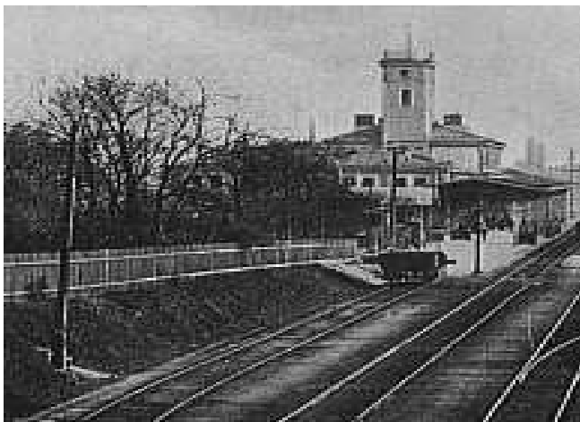
Rys. 1. Słupy linii telegraficznej, na tle dworca DŻWW w Częstochowie, widok od strony Warszawy; fragment dziewiętnastowiecznej fotografii
