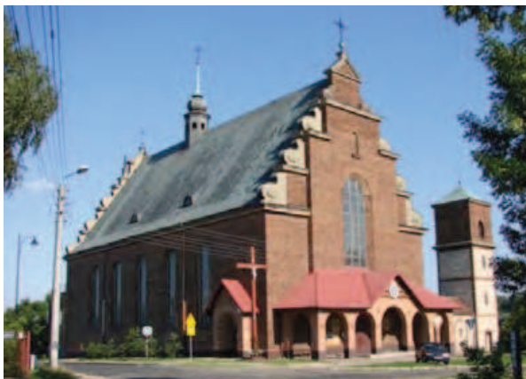
Fot. 3. Kościół pw. Podwyższenia Krzyża Św., widok od strony północno-zachodniej
