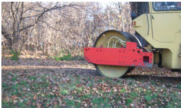
Rys. 3. Zdjęcie walca wibracyjnego w czasie pomiarów
