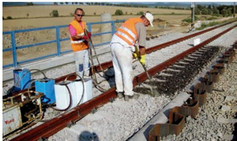
Aplikacja systemu MC-Ballastbond firmy MC-Bauchemie
