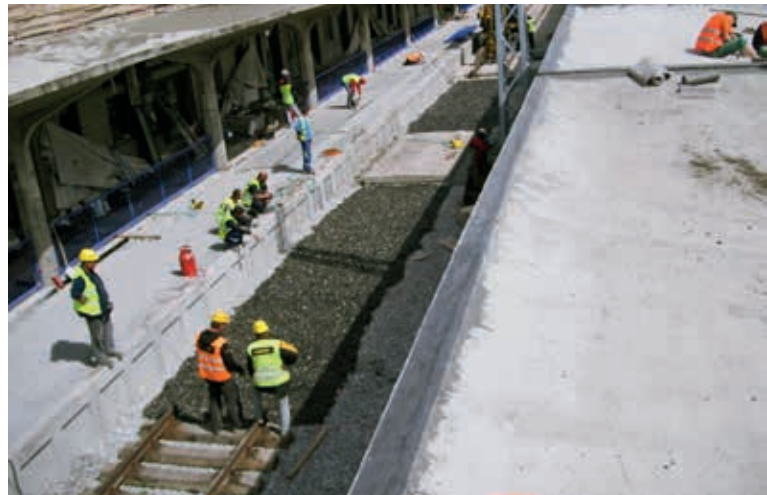
Remont stacji České Velenice w Czechach
