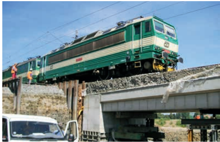
Remont obiektów inżynierskich na linii kolejowej w Czechach
