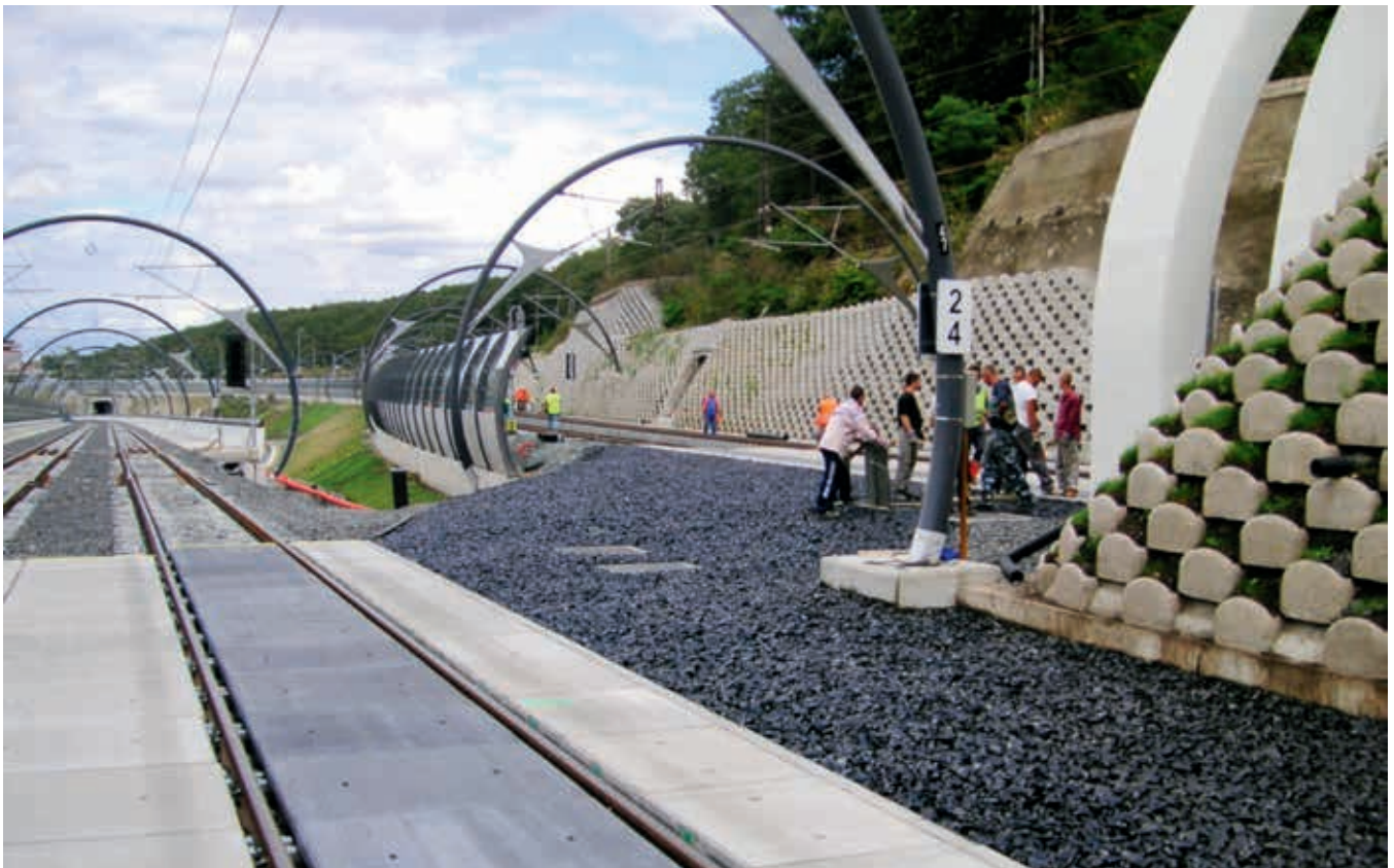
Zabezpieczenie możliwości ruchu na drogach ewakuacyjnych – obwodnica Pragi czeskiej
