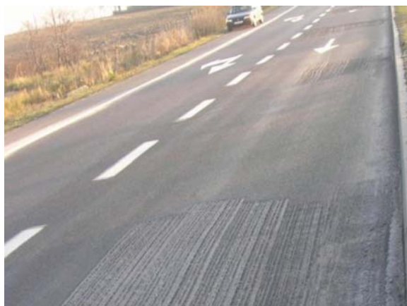
Rys. 5. Widok na odcinek km 189+ 070 ÷ 189+155: (a) sfrezowane wypiętrzenia na- wierzchni w strefie odkształceń dogęszczających, (b) wypiętrzenie krawężników w obszarze skrzy- żowania w km 189+074
