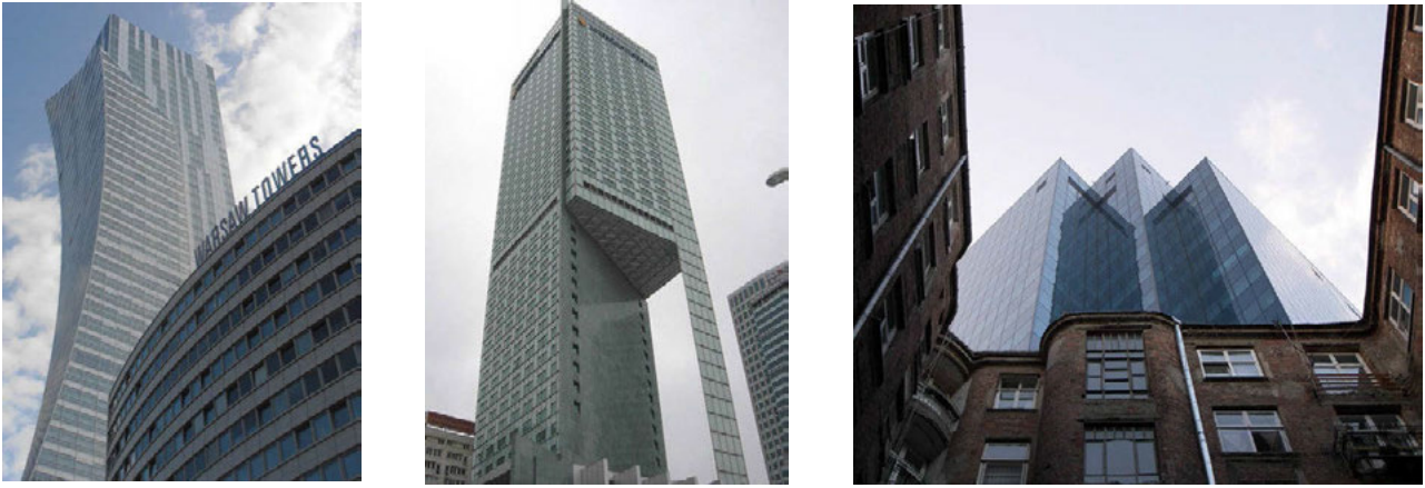
Il. 28, 29, 30. Ujęcia z dolnej perspektywy wybranych warszawskich budynków wysokościowych z widocznym efektem nachylenia się górnych części obiektów na skutek: zakrzywienia płaszczyzny elewacji (Złota 44 — il. 28), wycięcia dolnej części bryły (Hotel IC — il. 29) i poprzez częściowe nadwieszenie nad podwórkiem kamienicy (Moniuszki Tower — ill. 30) (fot. W. Oleński).
