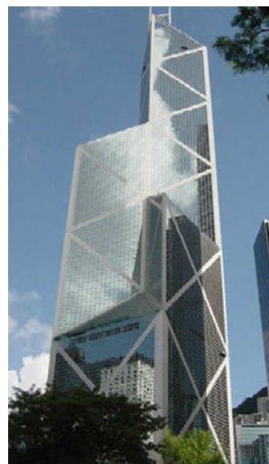
Il. 22, 23, 24, 25. Przykładowe widoki elewacji wieżowców w Nowym Jorku (il. 22–23), Hong Kongu (il. 24) i Tokio (il. 25) z różnymi modułami podziałów i artykulacji fasady zmieniające postrzeganie ilości kondygnacji i proporcji wież (fot. W. Oleński).
