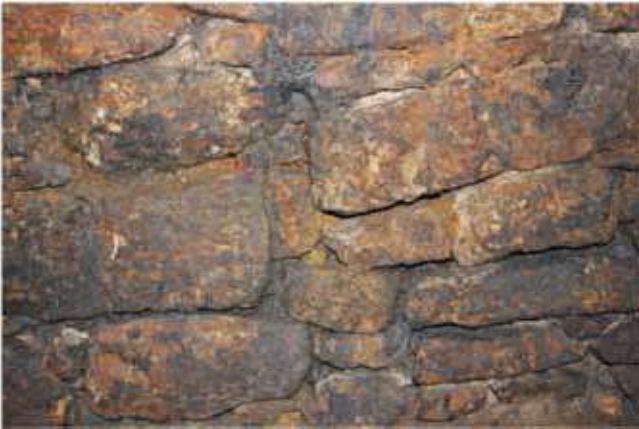
Rys. 9. Obudowa murowa z kamienia (piaskowiec) w odcisie historycznego wyrobiska
