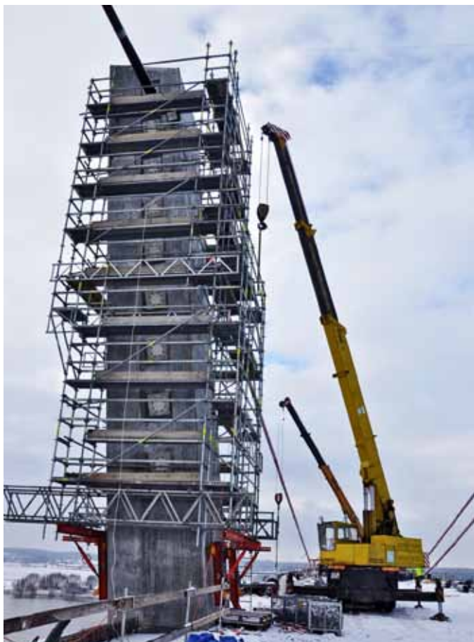
Montaż pierwszych want na moście głównym, luty 2013 r.
