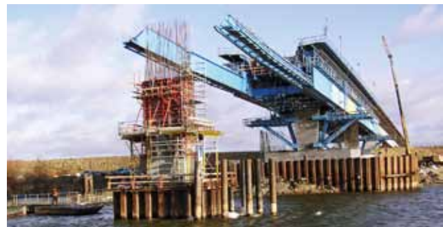
Budowa mostu głównego metodą rusztowania przestawnego od strony wschodniej, styczeń 2012 r.
