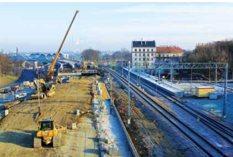
Powstająca łącznica kolejowa na wysokości przystanku Kraków Krzemionki (17.12.2016 r.)
