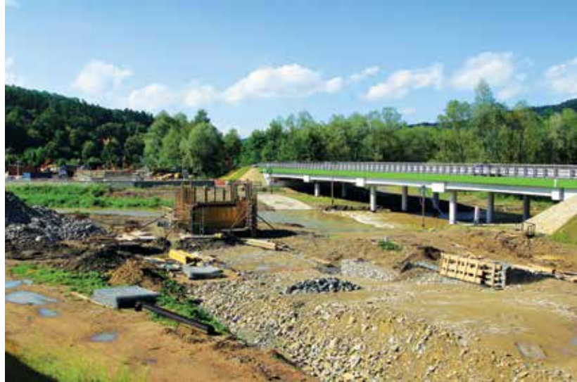
Początek budowy mostu na łącznicy w Suchej Beskidzkiej (03.07.2016 r.)
