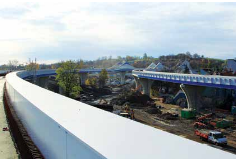
Widok na powstającą łącznicę w kierunku przystanku Kraków Krzemionki (05.11.2016 r.)
