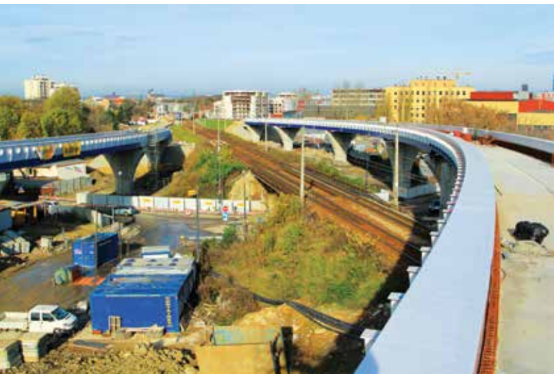
Początkowy odcinek powstającej łącznicy od strony przystanku Kraków Zabłocie (05.11.2016 r.)
