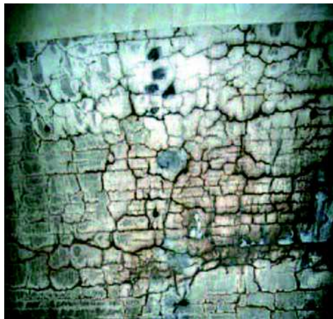
Fot. 2. Typowy obraz szkodliwego działania reakcji pomiędzy alkaliami a aktywną krzemionką kruszywa [6]
