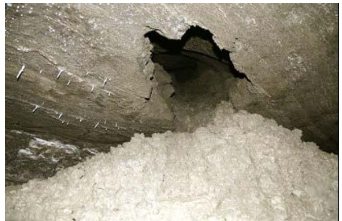
Ryc. 4. Szczelina w stropie oraz nagromadzenie materiału skalnego wynoszonego do komory
