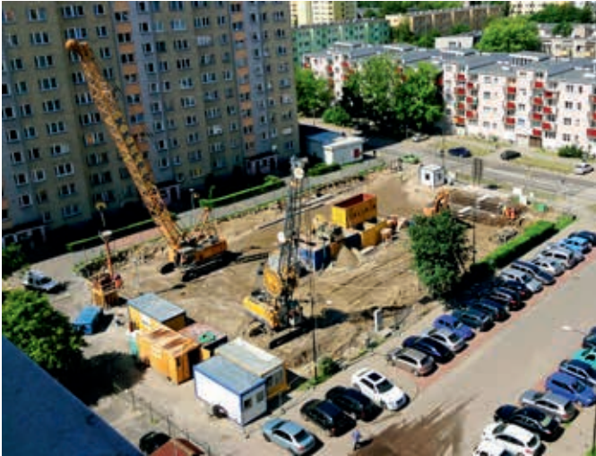
Ryc. 6. Warszawa, Stodowiec Park, kopanie ścian szczelinowych
