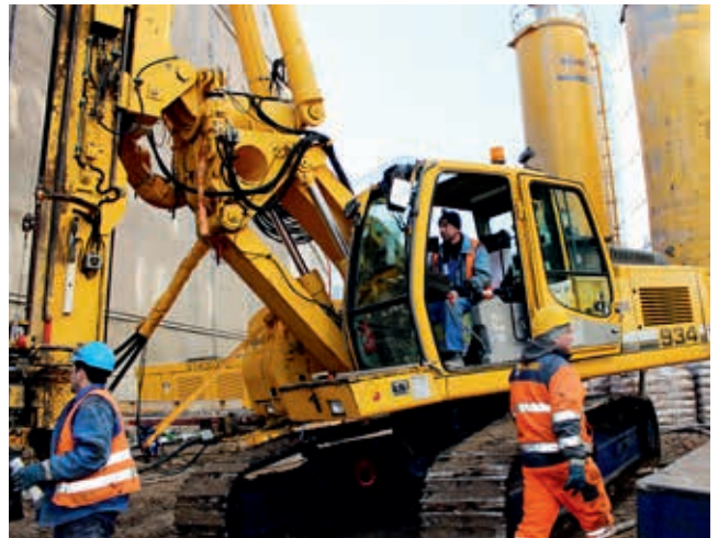
Ryc. 9. Warszawa, CBF, budynek – realizacja iniekcji – wąska przestrzeń między budynkami istniejącymi
