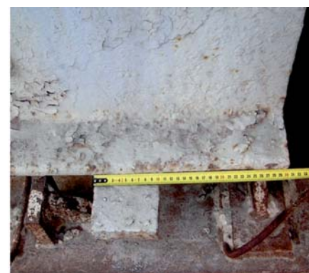
Fot. 2. Łożyska belek stalowych: a) nieprzesuwne, b) łożysko styczne przesuwne
