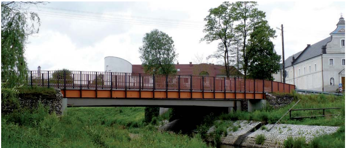
Fot. 3. Kładka dla pieszych w Biłgoraju (2007 r.), w bezpośrednim sąsiedztwie mostu sprężonego Cz. Eimera, wg projektu z 1955 r.
