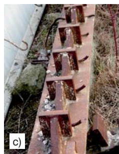
Fot. 1. Odzyskane belki stalowe, w formie tandemów, z łącznikami sztywnymi: a) widok na poprzecznice skrajną, b) połączenie poprzecznic z belką, c) łączniki sztywne, d) łączniki wiotkie
