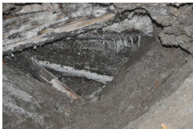
Ryc. 6. Zniszczona ostatnia obudowa w Poprzeczniku 2 Fig. 6. Damaged wooden roof housing in Crosscut 2
