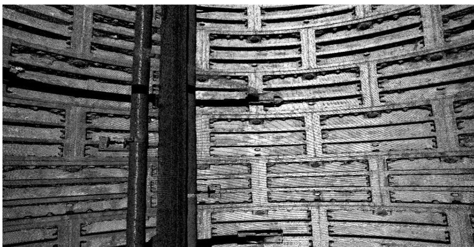
Rys 11. Widok chmury punktów scalonej z trzech skanerów, uzyskanej z pomiaru platformą podczas mobilnego skanowania rury szybowej (Adamek et al. , 2014)
