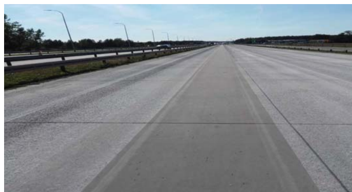
Fot. 4. Widok nawierzchni drogi betonowej S8 na odcinku Wolbórz–Polichno po wykonaniu pierwszego przejazdu urządzenia podczas zabiegu szlifowania podłużnego nawierzchni ( grindingu ) – zdjęcie DTB
