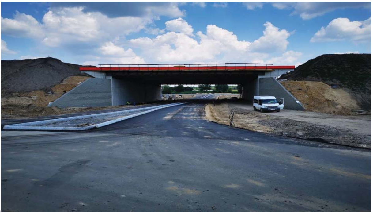
Fot. 5. Obiekt inżynierski WS-62,0 na drodze krajowej S7, odcinek Pieńki-Płońsk, na którym zastosowane zostaną dylatacje polimerowe na styku betonowej płyty pomostu obiektu i drogowej nawierzchni betonowej (zdjęcie Oddział GDDKiA Olsztyn)
