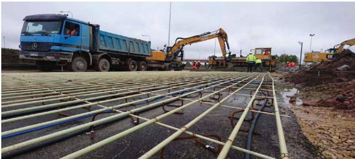
Fot. 2. Zbrojenie ciągłe epoksydowo-szkłane GFRP na 100-metrowym odcinku betonowym C35/45 jezdni manewrowej JM1W MOP Starcza Wschód, A1H – odcinek doświadczalny (zdjęcie Oddział GDDKiA Katowice)
