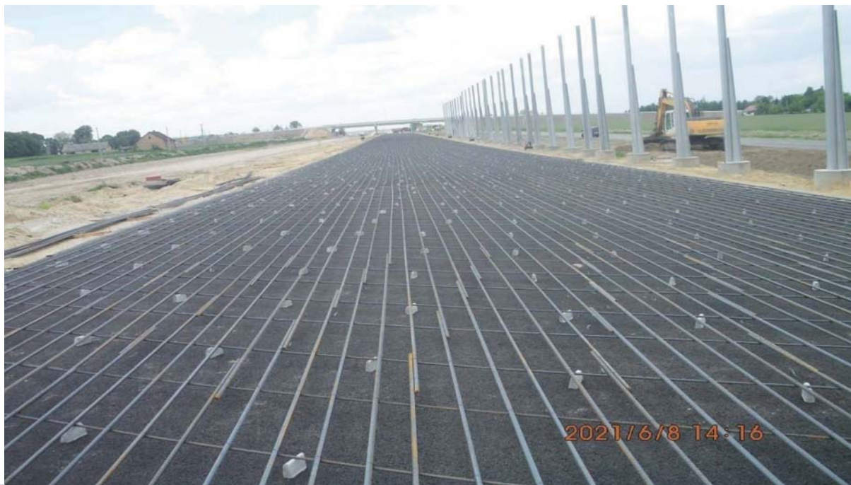
Fot. 7. Widok zbrojenia ciągłego na 2-kilometrowym odcinku doświadczalnym nawierzchni betonowej drogi krajowej S7, odcinek Pieńki–Płońsk (zdjęcie Oddział GDDKiA Olsztyn)
