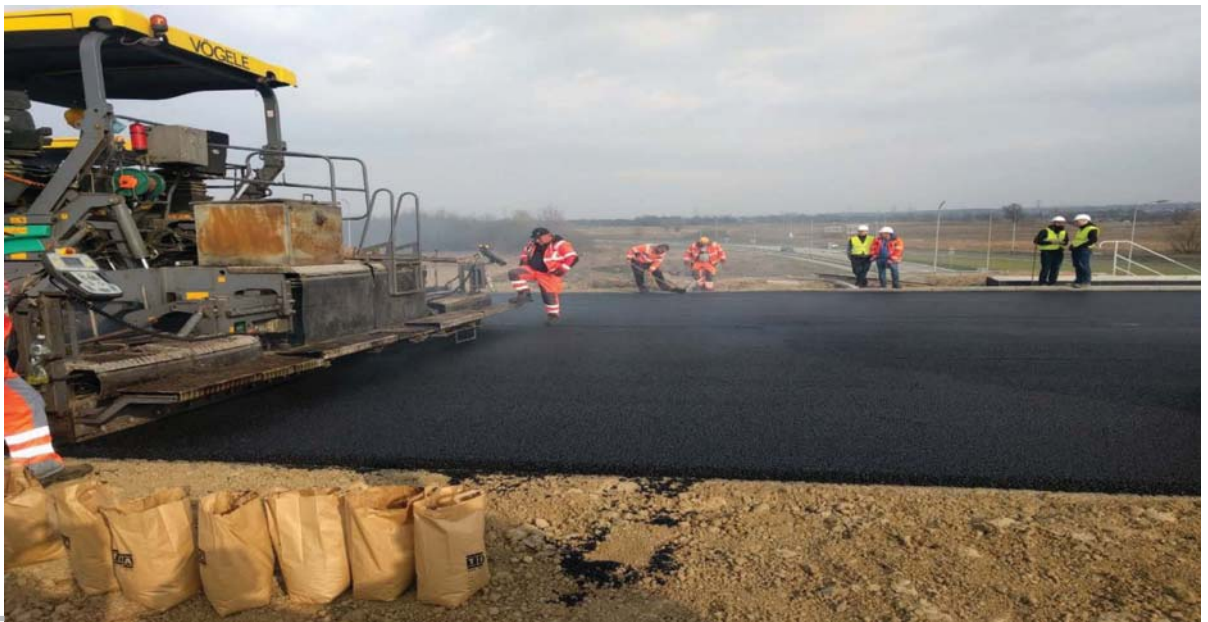
Fot. 9. Mieszanki asfaltowe z dodatkiem gumy (AMG). Rozkładanie mieszanki AMG na odcinku Rybitwy–Igołomska na drodze krajowej S7 (zdjęcie Oddział GDDKiA Kraków)
