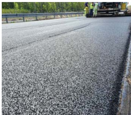
Fot. 13. Widok warstwy ścieralnej nawierzchni z dodatkiem granulatu asfaltowego w trakcie zagęszczania (fotografia lewa) oraz po jej uszorstnieniu (fotografia prawa), droga krajowa S3 odcinek Miękowo–Rzęśnia (zdjęcie Oddział GDDKiA Szczecin)
