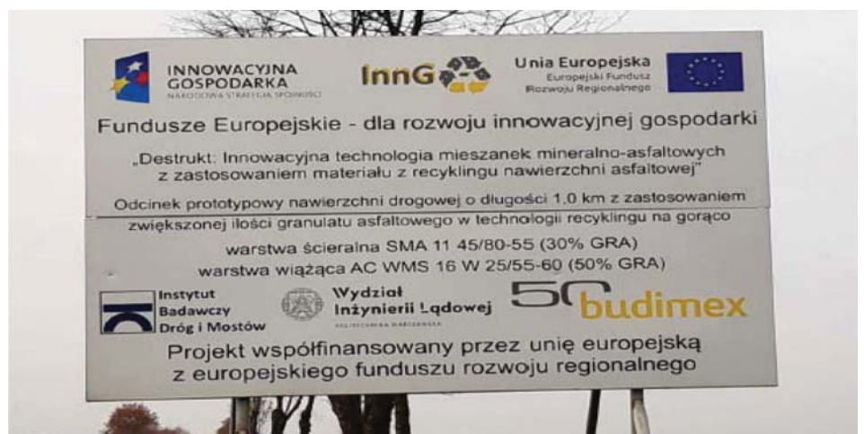
Fot. 11. Tablica informacyjna o wykonanym odcinku doświadczalnym z zastosowaniem mieszank asfaltowych z dodatkiem destruktu, odcinki na drodze krajowej S7 k/Jędrzejowa (zdjęcie Oddział GDDKiA Kielce)
