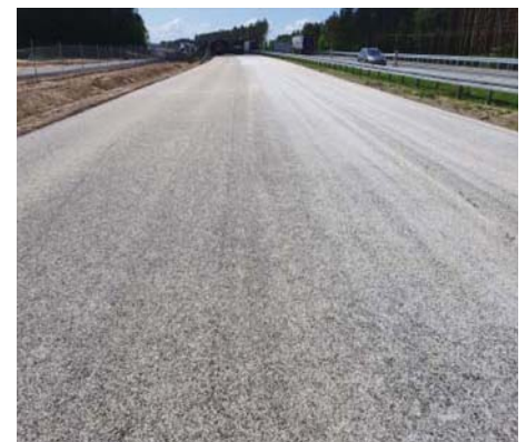
Fot. 13. Widok warstwy ścieralnej nawierzchni z dodatkiem granulatu asfaltowego w trakcie zagęszczania (fotografia lewa) oraz po jej uszorstnieniu (fotografia prawa), droga krajowa S3 odcinek Miękowo–Rzęśnia (zdjęcie Oddział GDDKiA Szczecin)
