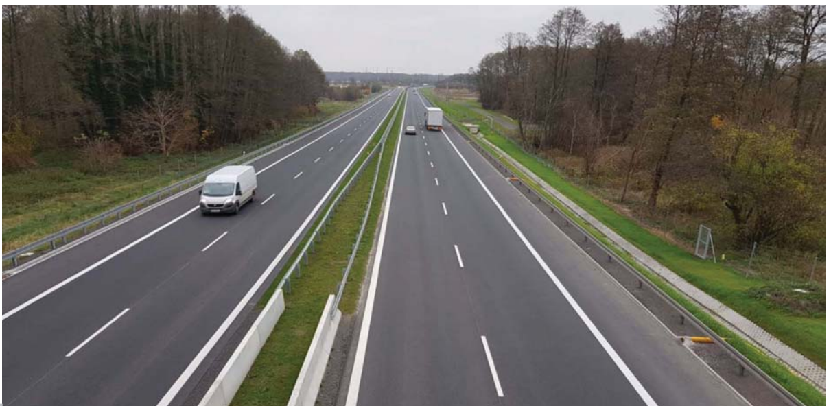
Fot. 10. Odcinek drogi krajowej S3 Sulechów–Zielona Góra Północ z warstwą ścierną SMA AMG (zdjęcie Oddział GDDKiA Zielona Góra)
