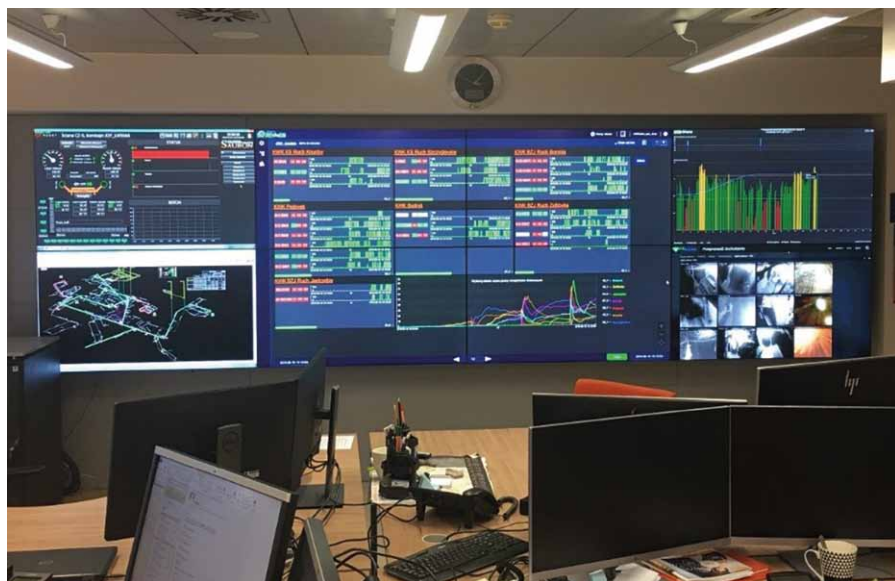
Rys. 1. Pomieszczenie Centrum Zaawansowanej Analityki Danych
