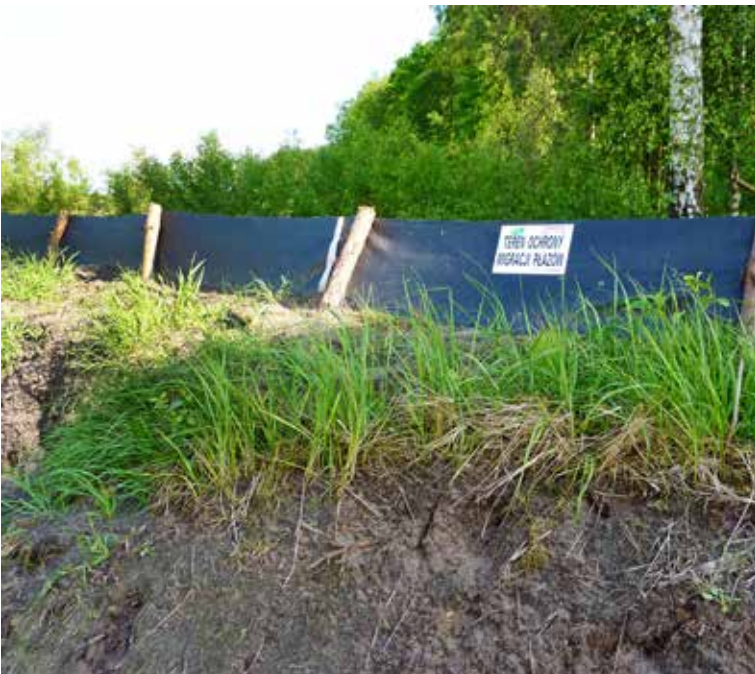
Ryc. 5. Przykład tymczasowego ogrodzenia terenu inwestycji dla ochrony herpetofauny z zastosowaniem płotków wykonanych z tworzyw sztucznych, fot. A. Wysokowski
