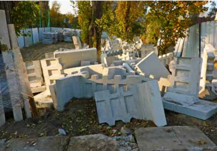
Ryc. 3. Przykłady nieprawidłowego składowania na placu budowy żelbetowych elementów do wykonywania konstrukcji ścian oporowych, fot. A. Wysokowski
