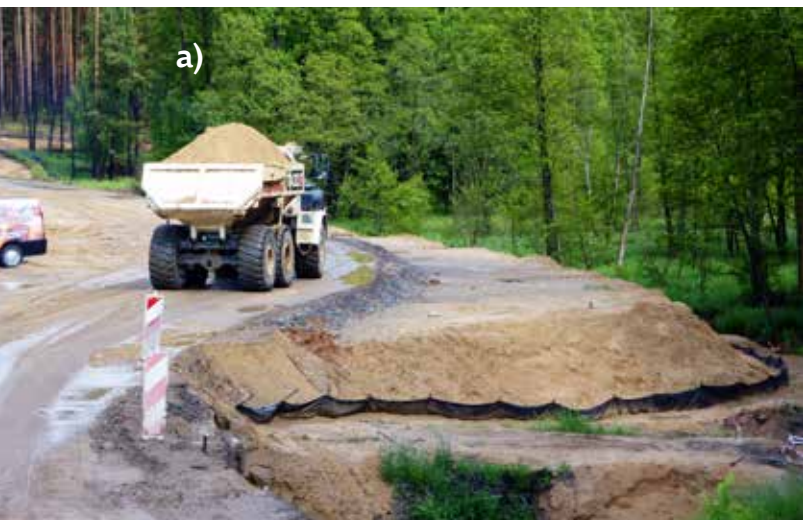
Ryc. 4. Przykład konstrukcji dróg tymczasowych do obsługi inwestycji: a) droga tymczasowa wykonana w technologii kruszywowej – widoczne zabezpieczenie drogi płótkami przed herpetofauną, b) droga tymczasowa w obrębie inwestycji liniowej – na pierwszym planie widoczny tymczasowy przepust z blach falistych, fot. A. Wysokowski
