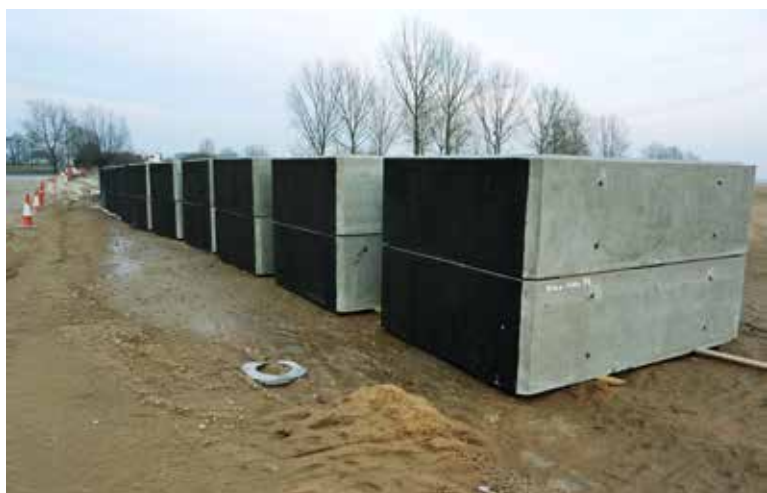
Ryc. 2. Przykład składowania na placu budowy prefabrykatów żelbetonowych o przekroju skrzynkowym do budowy przepustu pod koroną drogi klasy A, fot. A. Wysokowski
