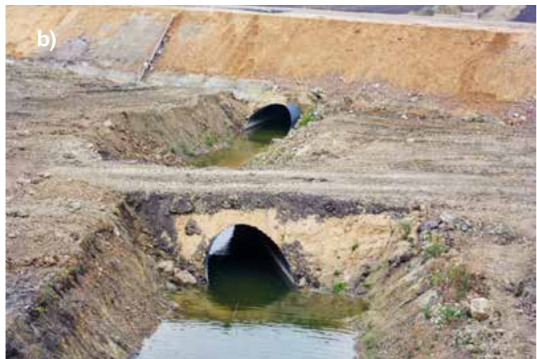
Ryc. 4. Przykład konstrukcji dróg tymczasowych do obsługi inwestycji: a) droga tymczasowa wykonana w technologii kruszywowej – widoczne zabezpieczenie drogi płótkami przed herpetofauną, b) droga tymczasowa w obrębie inwestycji liniowej – na pierwszym planie widoczny tymczasowy przepust z blach falistych, fot. A. Wysokowski
