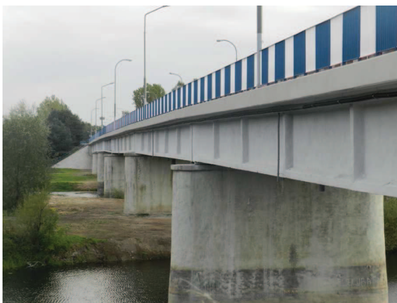
Rys. 4. Widok ogólny mostu
