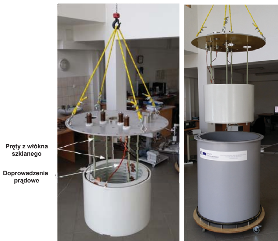
Rys. 7.11. Nadprzewodnikowy ogranicznik prądu zwarciego podczas montażu: a) uzwojenia ogranicznika podwieszane do pokrywy kriostatu, b) ogranicznik podczas montażu w kriostacie azotowym
