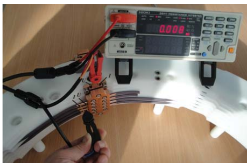
Rys. 6.31. Pomiar rezystancji połączeń pomiędzy miedzianym drutem nawojowym a miedzianym blokiem połączeniowym pierwotnego uzwojenia miedzianego ogranicznika (metoda czteroprzewodowa)
