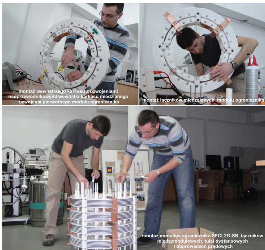
Rys. 6.15. Montaż ogranicznika 6,9 kV / 600 A
