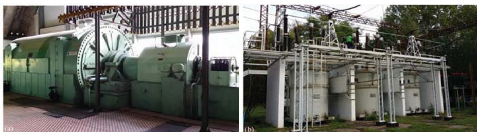
Rys. 7.59. (a) Generator o mocy zwarciovych 2500 MVA, (b) trzy jednofazowe transformatory zwarciovych kazdy o mocy 750 MVA
