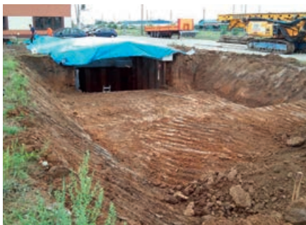
Rys. 9. Komora badawcza oraz wykop pod odcinek dojazdowy
