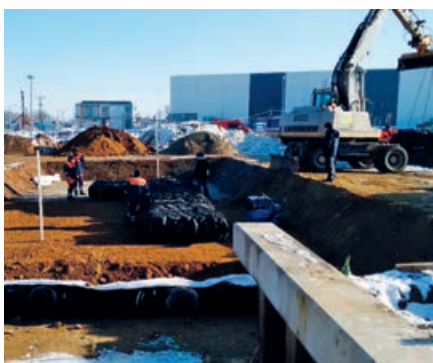
Rys. 10. Wypełnianie odcinka dojazdowego pakietami
