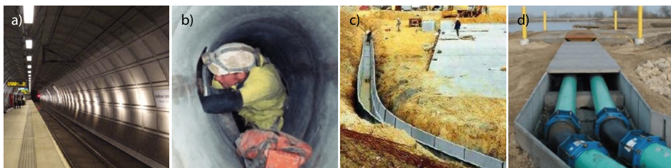
Rys. 5. Panele z GFRK dla tuneli [30] (a), panele z GFRK dla kanalizacji miejskich [31] (b), panele z GFRK dla systemów melioracyjnych [32] (c), kanały z GFRK do ochrony rur elektrycznych [33] (d)
