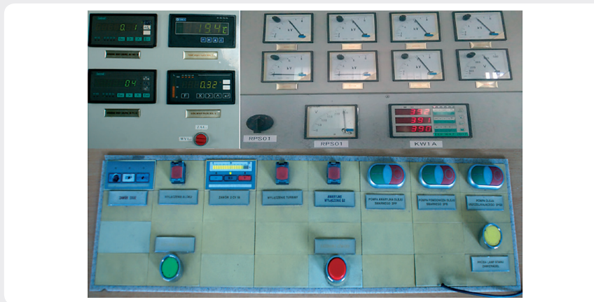
Fot. 1. Fragment dawnej nastawni z aparaturą kontrolno-pomiarową
