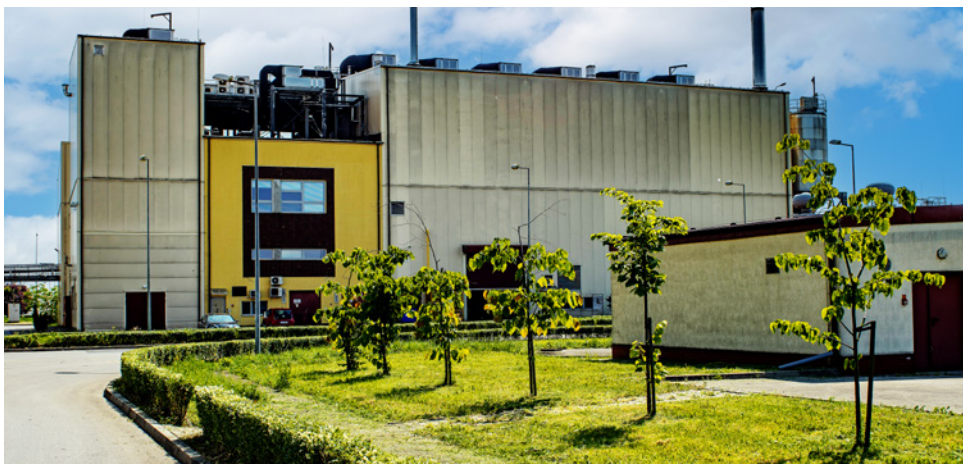
Stacja termicznej utylizacji osadów
