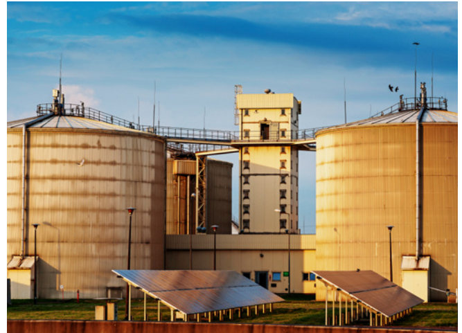
Wydzielone komory fermentacyjne
