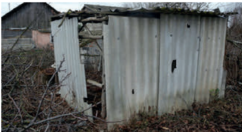
Fig.3. Derelict asbestos-cement boards on private property (Szczucin 2013) [fot. M. Glica] Rys. 3. Niszczące płyty azbestowo-cementowe na prywatnej posesji (Szczucin, 2013 r.) [fot. M. Glica]
