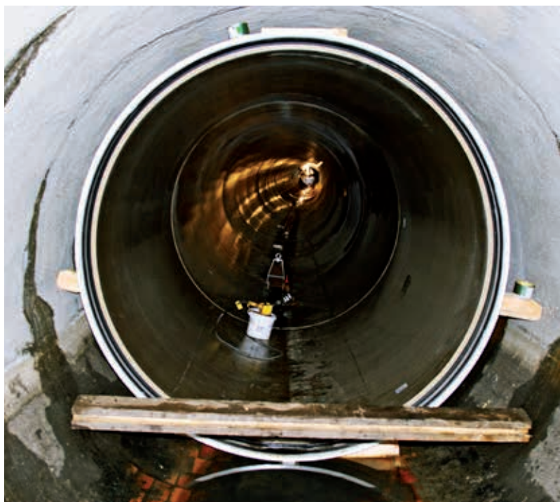
Stabilizacja rury DN 2000 drewnianymi klinami – kolektor Północny
