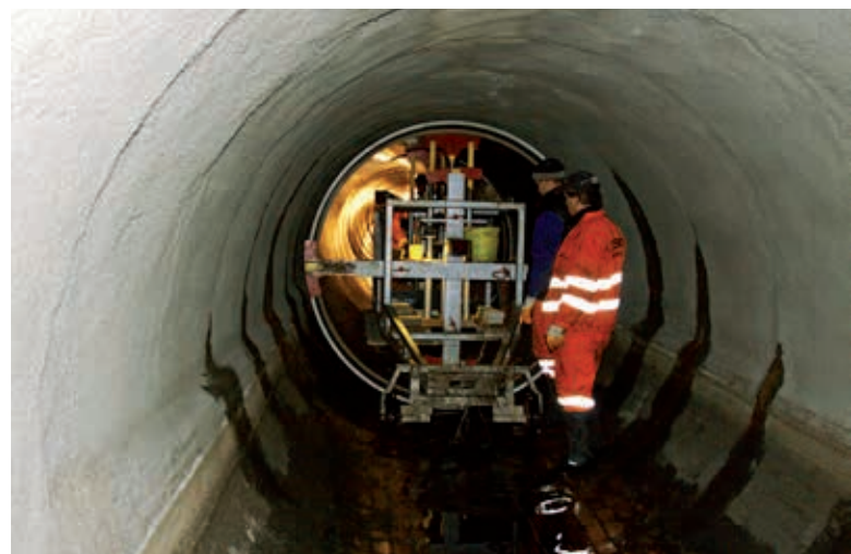
Montaż rur we wnętrzu naprawianego kolektora Północnego (widoczne przecieki połączeń)
