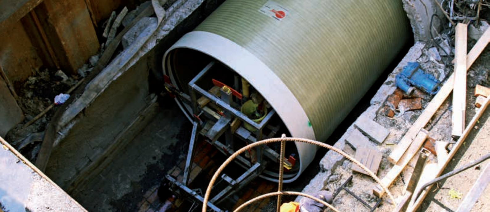
Transport rury do wnętrza kanału kolektora Północnego za pomocą specjalnego wózka
