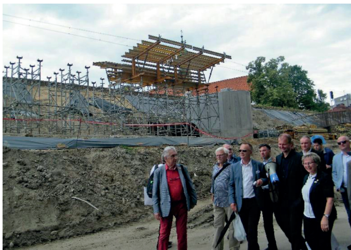
Fot. 11. Wizyta na budowie drugiej pary torów na szlaku Kraków Główny–Kraków Płaszów przez uczestników przejazdu pociągu „TLK Malinowski”, 15 czerwca 2018 r.
