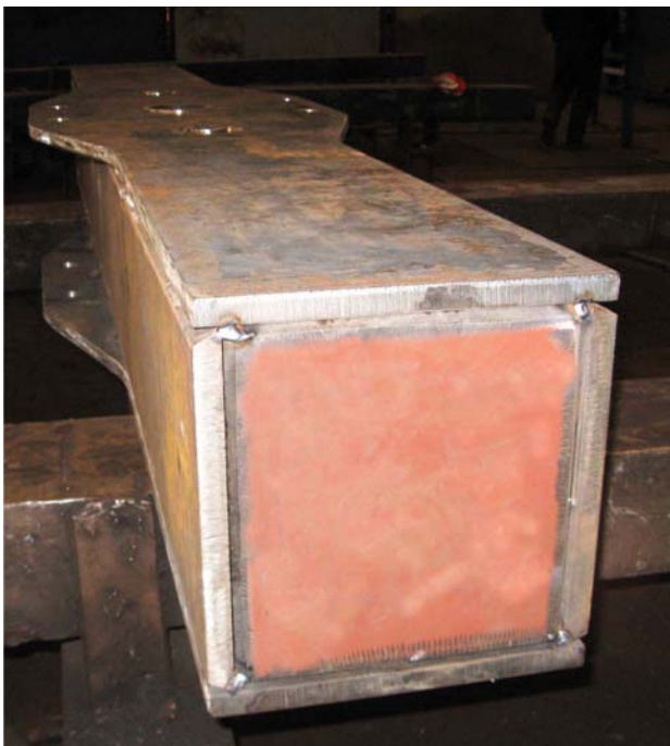
Ryc. 22. Rygiel jarzma przed spawaniem Fig. 22. Yoke beam before welding
