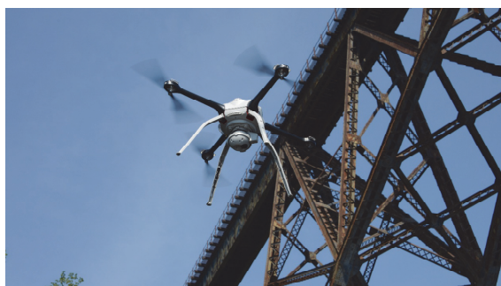
Rys. 2. Dron podczas przeglądu obiektu mostowego [2]
