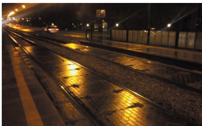
Rys. 6. Brak barierki rozdzielających torowiska na przystanku Katedra
