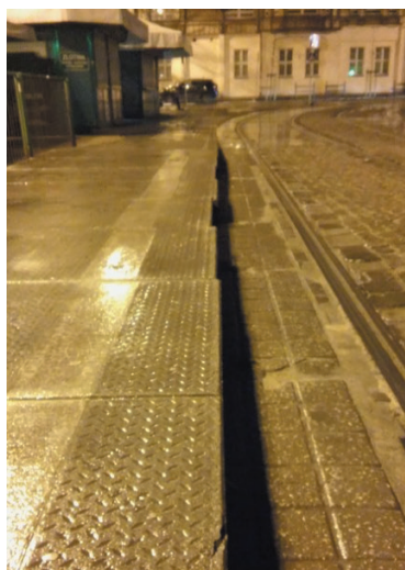
Rys. 1a. Uszkodzona nawierzchnia oraz krawędź peronu przystanku Serafitek, (b) nierówna krawędź peronu przystanku Plac Wielkopolski.
