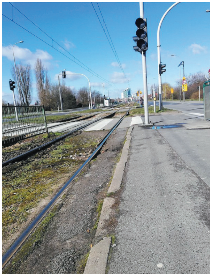
Rys. 5. Brak oznaczenia krawędzi peronu na przystanku Serafitek
