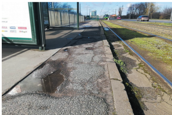
Rys. 1a. Uszkodzona nawierzchnia oraz krawędź peronu przystanku Serafitek, (b) nierówna krawędź peronu przystanku Plac Wielkopolski.
