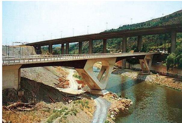
Fig. 18. Julio M. Calzon, “del Diabolo” bridge over the Llobregat river, Martorell (Barcelona), 1975 (100 m)
