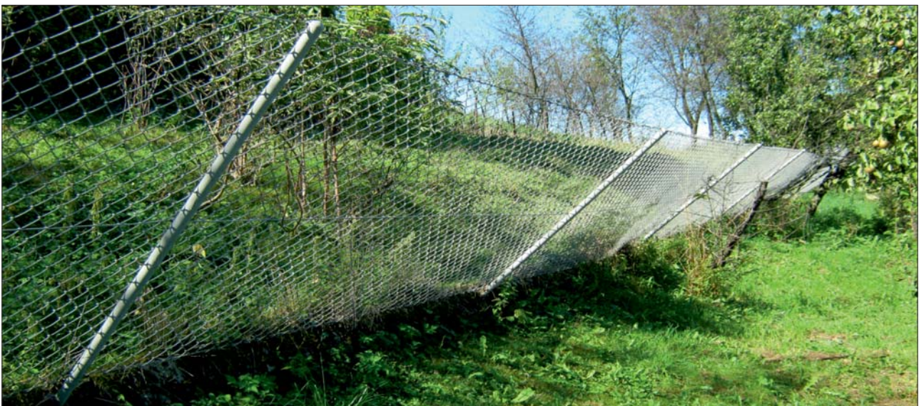
Uszkodzone i pochylone ogrodzenie w rejonie skarpy głównej osuwiska w Starym Sączu. Fot. J. Kos Damaged and inclined fence in the area of the main landslide scarp in Stary Sącz. Photo by J. Kos
