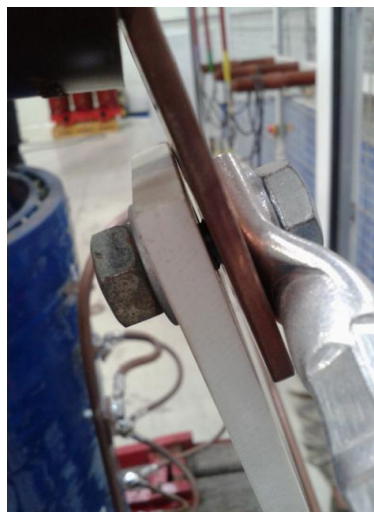
Rys. 4. Przykład nieodpowiedniego dokręcenia styku
