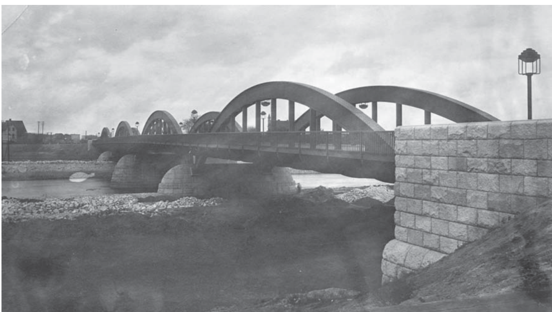
Fot. 5. Rosenthaler Brücke – widok z lewego brzegu Starej Odry od strony wody dolnej (źródło: Biblioteka Cyfrowa Uniwersytetu Wrocławskiego)
