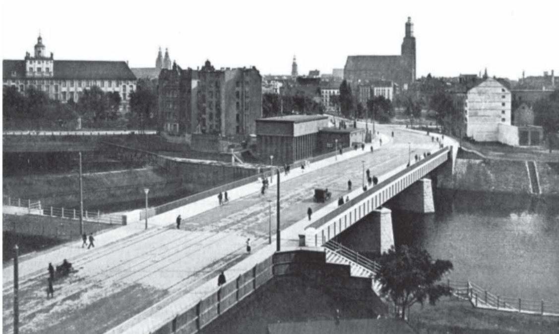
Fot. 7. Most Pomorski Północny – widok ogólny w kierunku południowym [1]
