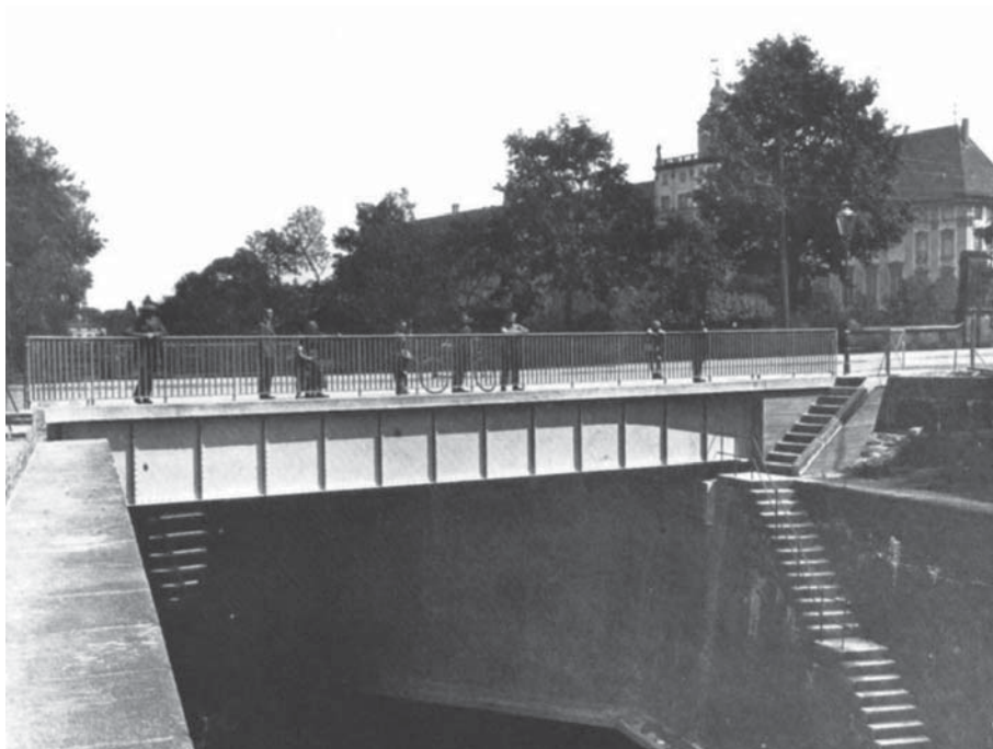
Fot. 6. Most Pomorski Środkowy – widok nowej konstrukcji od strony wody dolnej [1]
