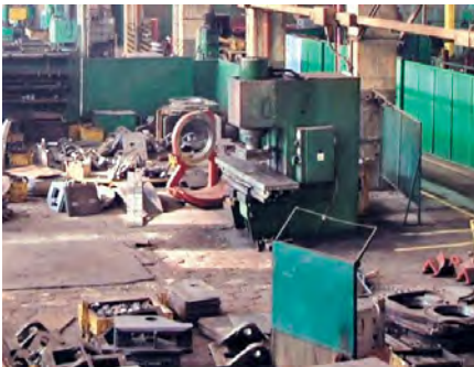
Rys. 3. Posadzka z betonowej kostki, tzw. trylinki, w hali przemysłowej (fot. autorzy)
