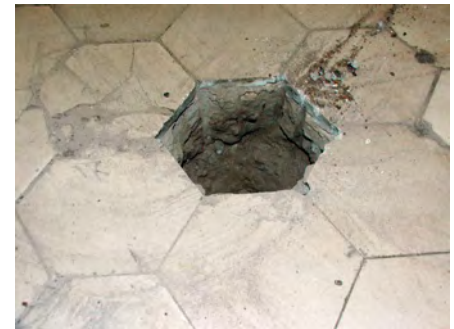
Rys. 5. Odkrywką starej posadzki z płytek terakotowych na betonowym podkładzie (fot. autorzy)
