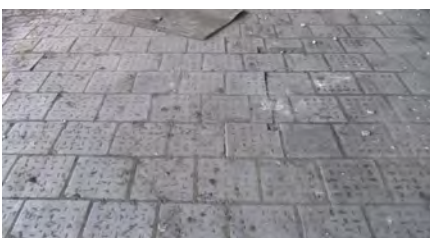
Rys. 6. Posadzka z płytek metalowych w hali walcowni (fot. autorzy)
