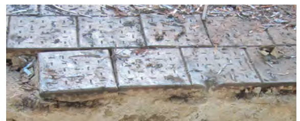
Rys. 5. Odkrywką starej posadzki z płytek terakotowych na betonowym podkładzie (fot. autorzy)
