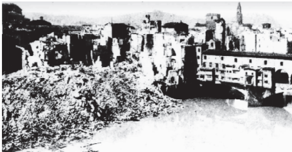
Ryc. 2. Stan zniszczeń północnego brzegu Arno w 1945 Fig. 2. War damage on the northern bank of the Arno in 1945
